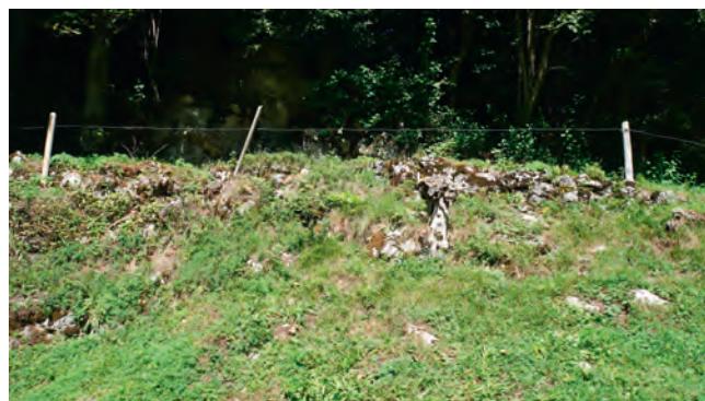
Abb. 9. Lungern OW-Alter Passweg, Abschnitt 2 (OW 2015.002). Blick vom Sewli-Dossen (Osten) auf die aus grossen Kalksteinen errichtete Trockenmauer, welche die talseitige Begrenzung des Passwegs in der Flur Chalhüttliwald bildet. Blick nach Norden. Foto S. Chamberlain.
